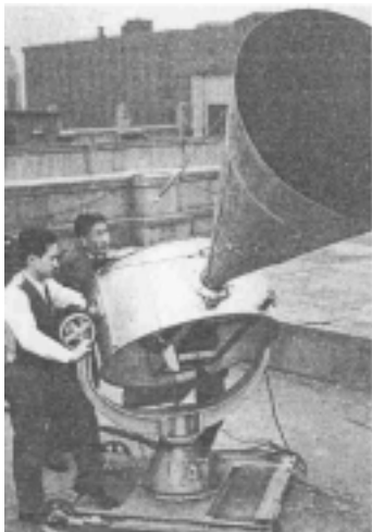
図7 大阪大学の3.3GHz ホーン受信機
